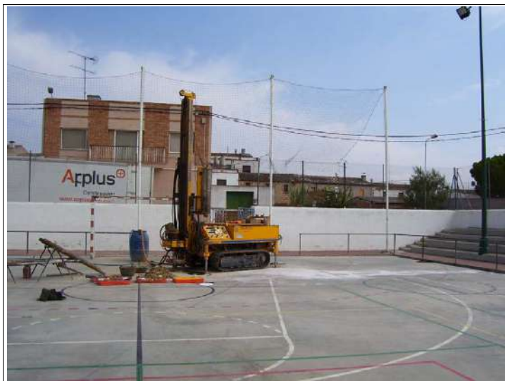
Fotografia 1. Màquina de rotació realitzant el punt S-1.
